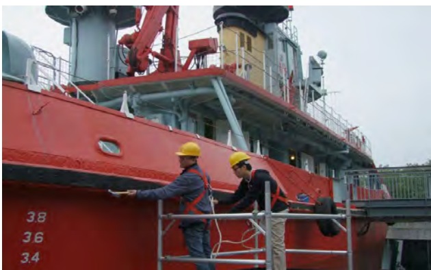
▲ 修复人员正在清理「葛量洪号灭火轮」的锈蚀
