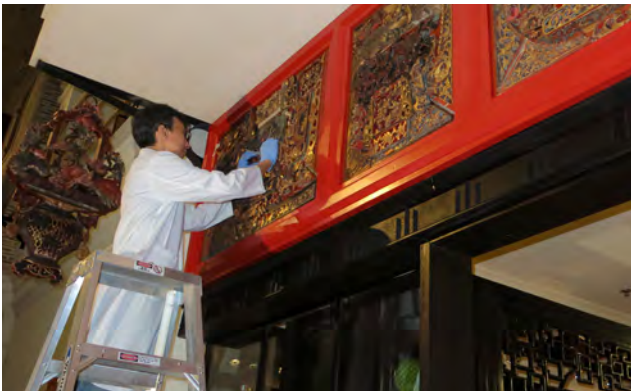
▲ 修复人员检查木雕，并重新装嵌脱落饰件
