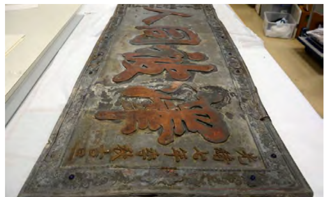
▲ 大澳杨侯古庙的金属牌匾现况欠佳
